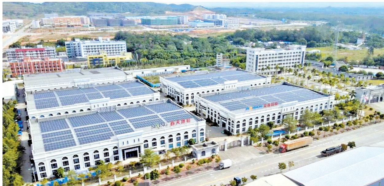
海丰金山科技产业园
