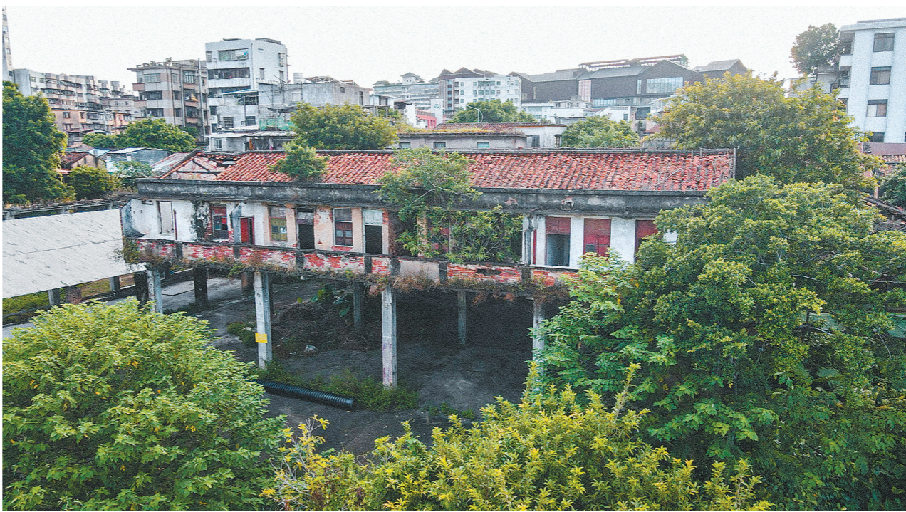
老船厂建筑仍然完整保留着
