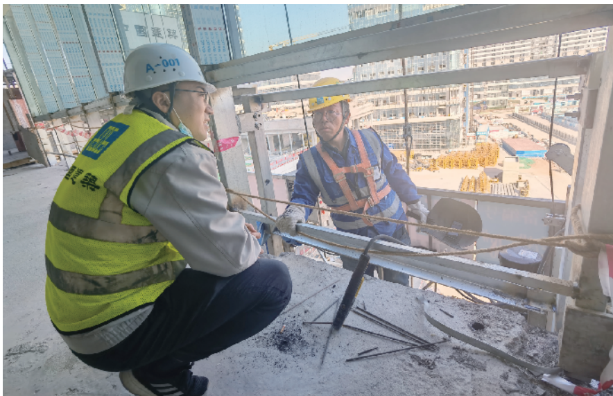
曹巍在工地现场排查安全隐患
