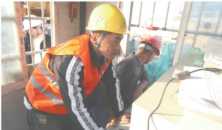
魏国豪在进行顶管机操作 誉建业/摄
