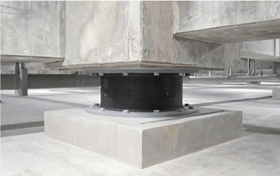
层压橡胶制成的隔震装置(图中黑色部分)
