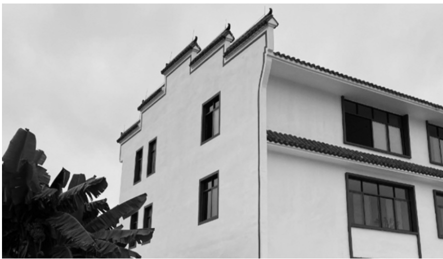
某村建筑不按本地传统风格，盲目采用徽派马头墙。
