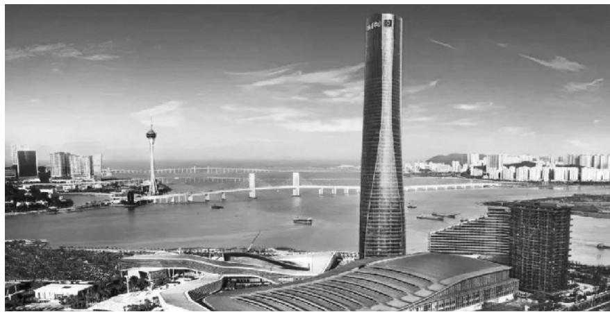
珠海十字门会展商务组团一期标志性塔楼工程 资料图片
