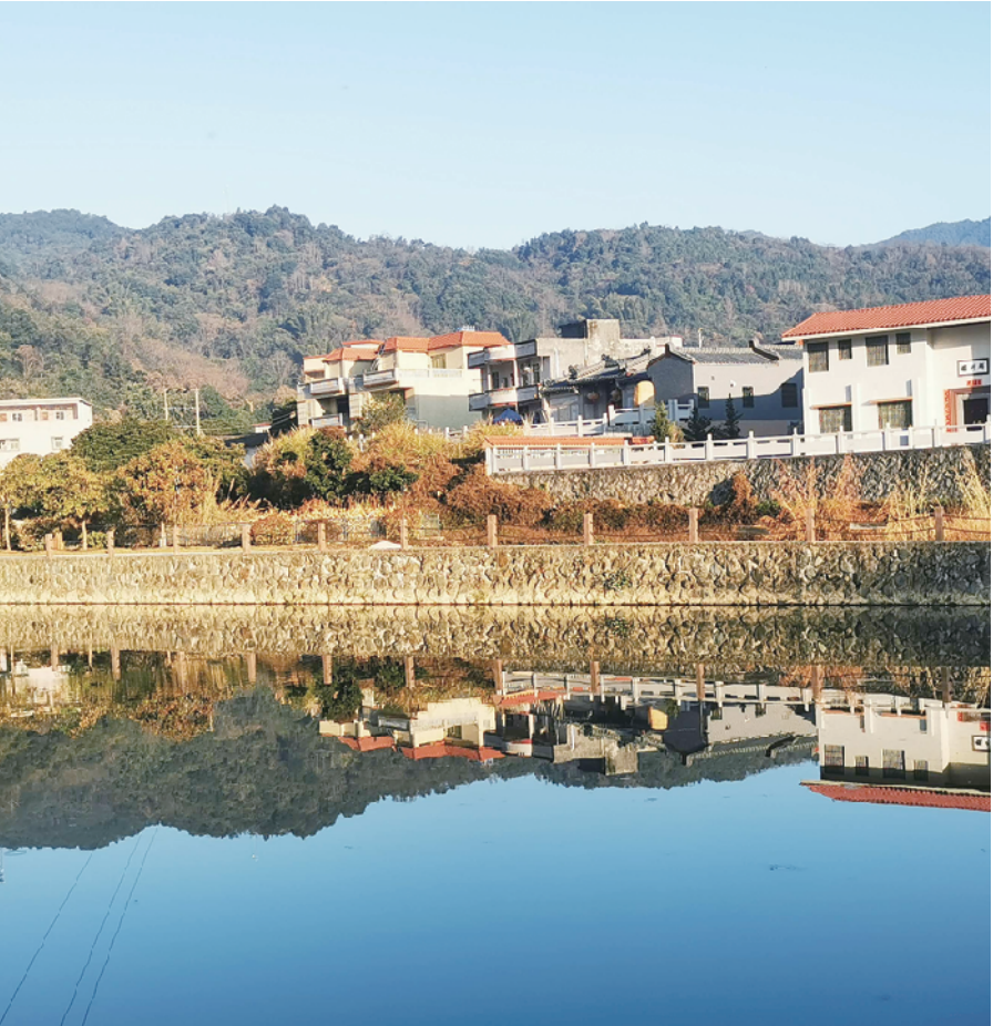
一河两岸建设成效图
