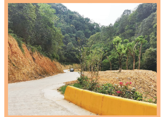
坪坑道路硬化化成效图
