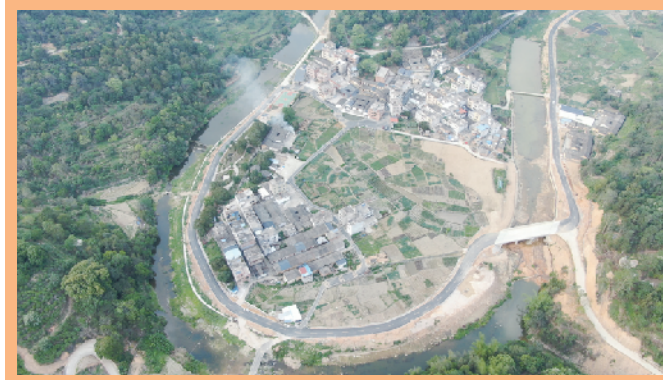
坪坑至Y128线新修道路图
