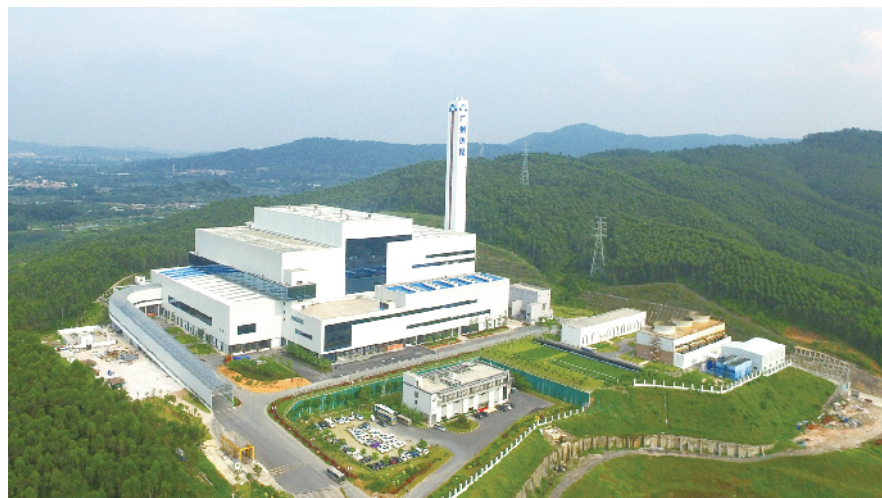
广州垃圾焚烧发电厂
