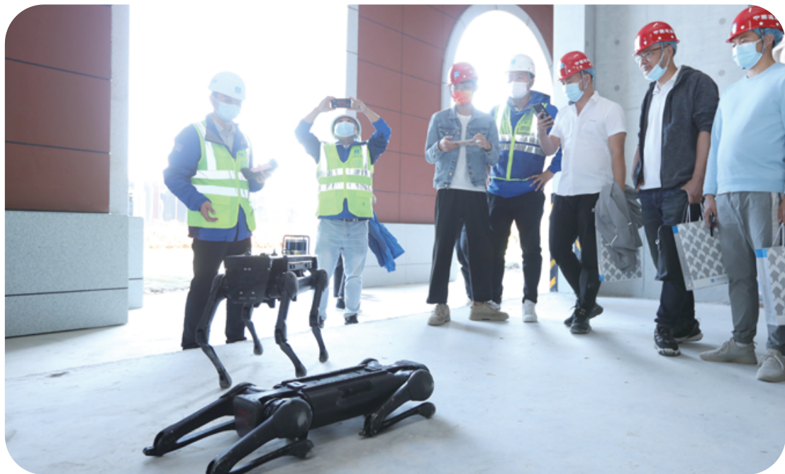
四足巡检机器人——机器人在工地已是常态。
