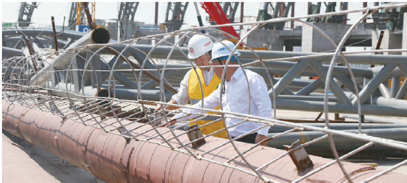
中铁建工集团广东有限公司安全总监张文辉、广州白云站项目安质环保部部长邱焕然现场检查钢结构爬梯焊缝
