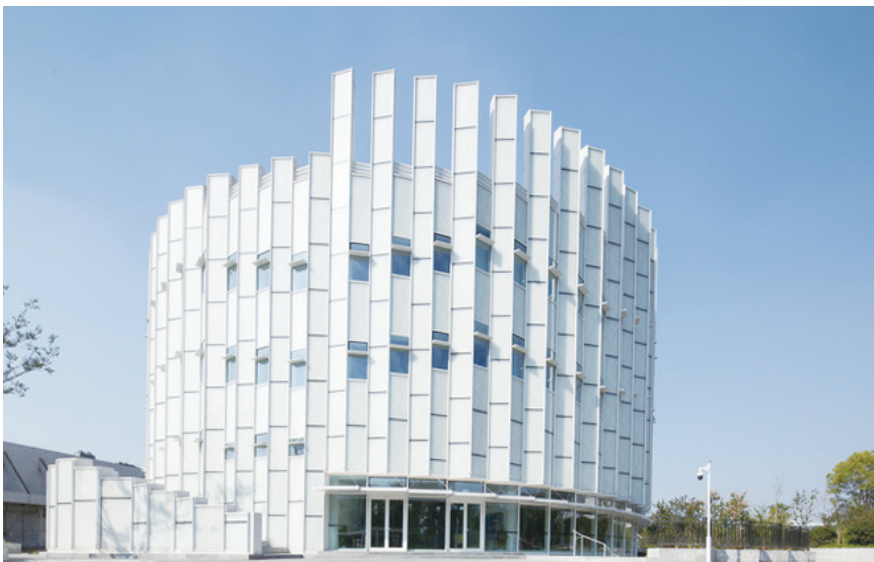
南京绿色灯塔在能源方面探索净零建筑的实现路径
