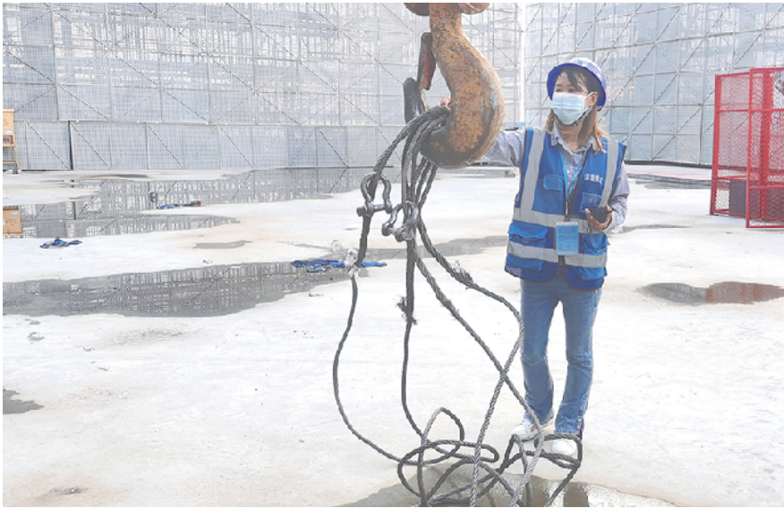
西安电子科技大学广州研究院项目信号工在进行塔吊吊具安全检查 誉建业 摄
