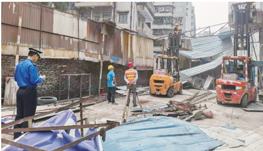
禅城城管会同街道强制拆除违法占用消防通道的铁皮棚
