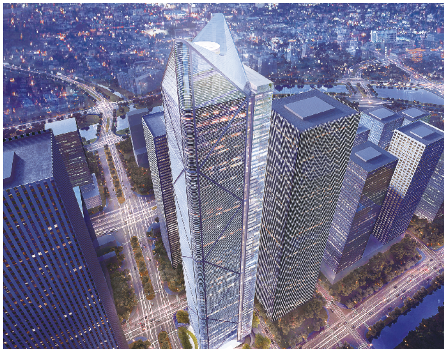
国内在建第一高纯钢结构超高层建筑——广商中心项目
