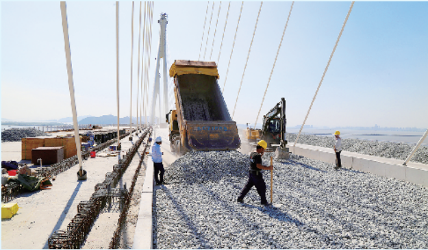
工人们正在进行底层道砟铺设施工 孟庆虎 摄
