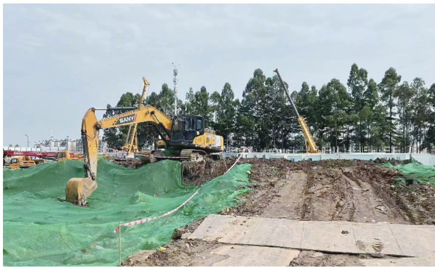
全面清理渣土和建筑垃圾
