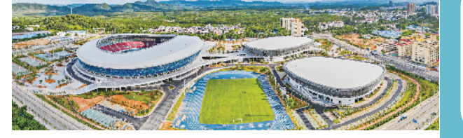
儋州体育中心项目
