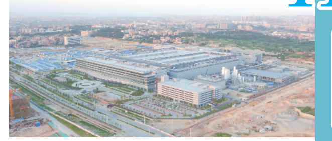
福建晋华存储器生产线
