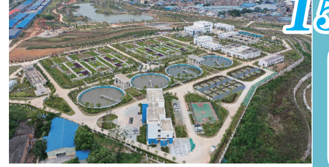
朝阳溪污水处理厂项目实景图
