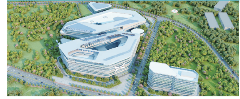
广州小鹏科技园主体总承包工程
