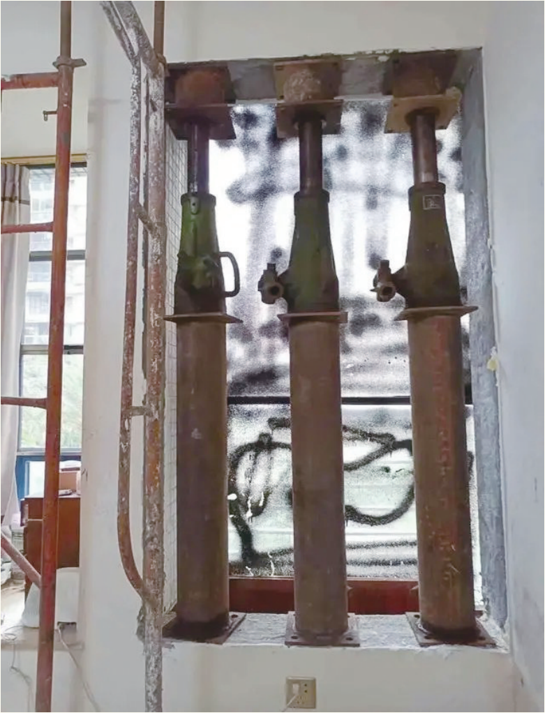
广州市白云区事发小区拆除承重墙后的临时加固
