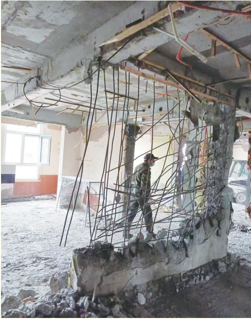
哈尔滨事件当中被拆除的承重墙
