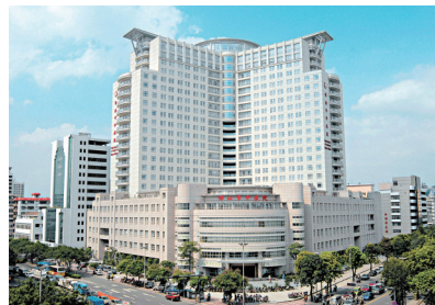
佛山市中医院医疗综合大楼 (中国建设工程鲁班奖)
