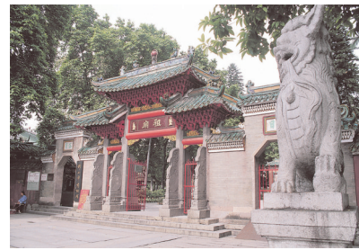
佛山祖庙修缮工程
