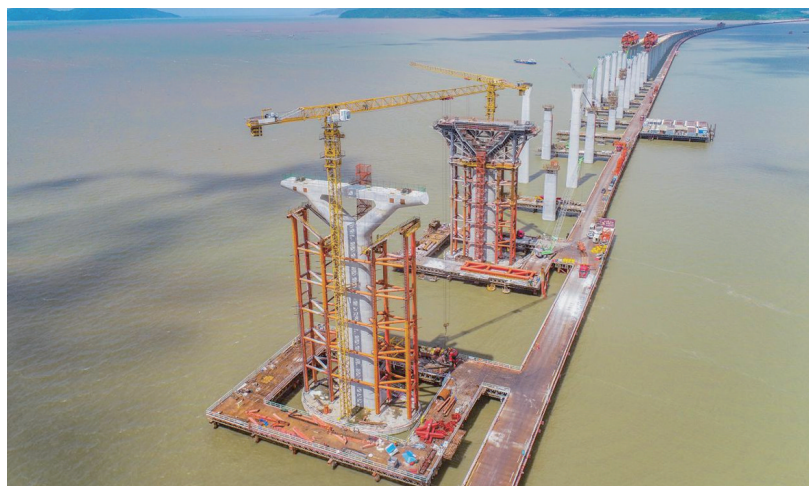
黄茅海跨海通道TY型墩完工现场
