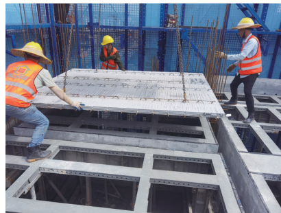
装配式预制构件板吊装
