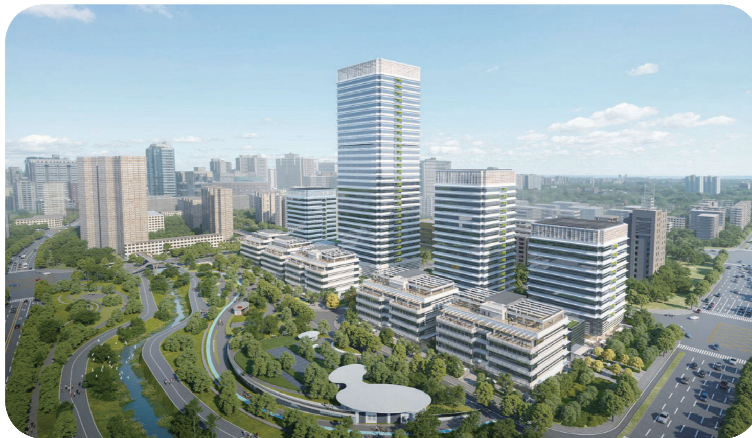
新城建示范及智能建筑产业园（一期）工程项目1-1A、1-2栋
