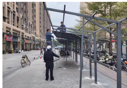
拆除未经审批的电动自行车充电棚（图源：禅城城管）
