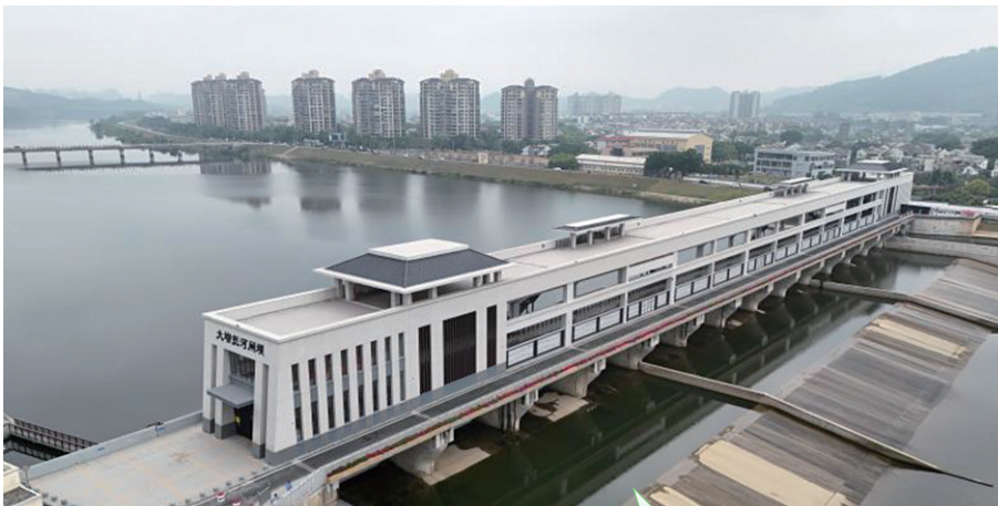
大坳拦河闸坝
