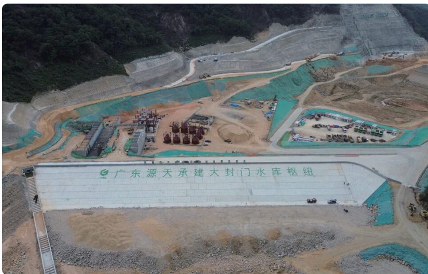
大封门水库扩容工程主体围堰（图源：广州增城发布）
