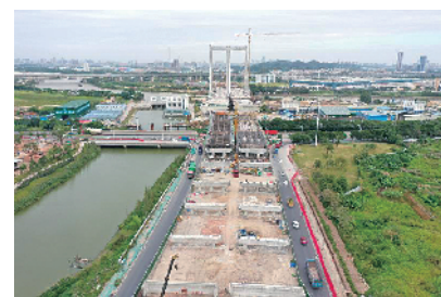
■番海大桥已经完成整体进度的70%。
