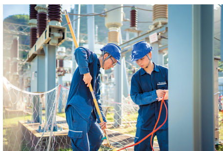
■两位试验人员正在整理“高空接线钳”及测试引线,为断路器回电电阻测试做好准备。
