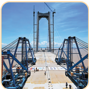
2022年6月28日，随着最后一块钢箱梁完成焊接作业，深中通道中山大桥正式合龙。
