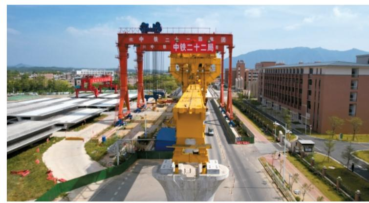
**箱梁**,桥梁工程中梁的一种,内部为空心状,上部两侧有翼缘,类似箱子,因而得名。钢筋混凝土结构的箱梁分为预制箱梁和现浇箱梁。预制箱梁在存梁场预先生产完成,后续由结合架桥机在下部工程完成后进行架设,可加速工程进度、节约工期。
