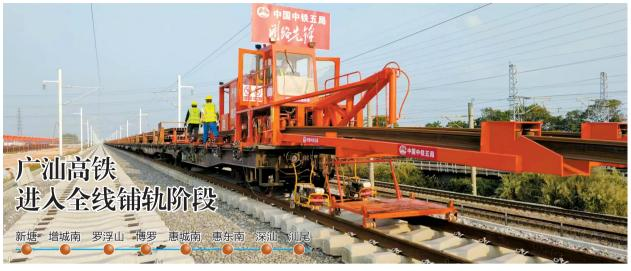
新快报讯 记者许力夫报道 11月 18日,在广州新塘广汕高铁施工现场, 随着牵引车将一对500米长轨平稳地 铺设到广汕高铁路基上,标志着广州至 汕尾的广汕高铁正式进入全线铺轨阶 段,朝着开通运营迈出了关键的一步。
