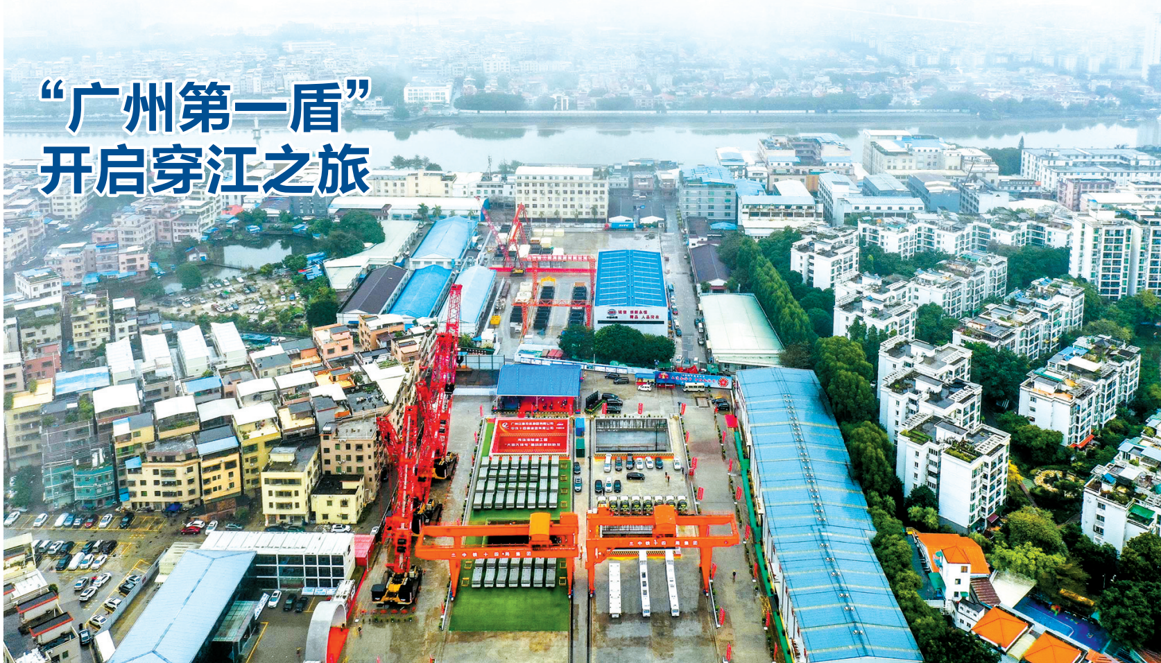
■昨日,广州最大盾构机——“大道先锋号”盾构机在海珠湾隧道工程西线隧道始发,海珠湾隧道以双管盾构隧道形式下穿珠江水道和洛溪岛,是广州首条超大直径市政盾构隧道。新华社发
