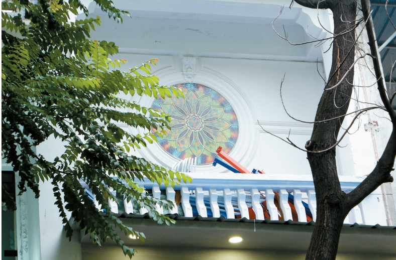
■传统风貌建筑线索杨巷路63号改建后,原八角形绿色窗及墙体被拆除,二楼水刷石柱、檐饰、栏杆被刷上白漆。(左图:改建前;右图:改建后)
