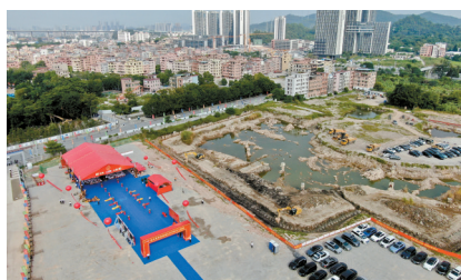
■黄埔区庙头旧村改造项目首开区开工现场
