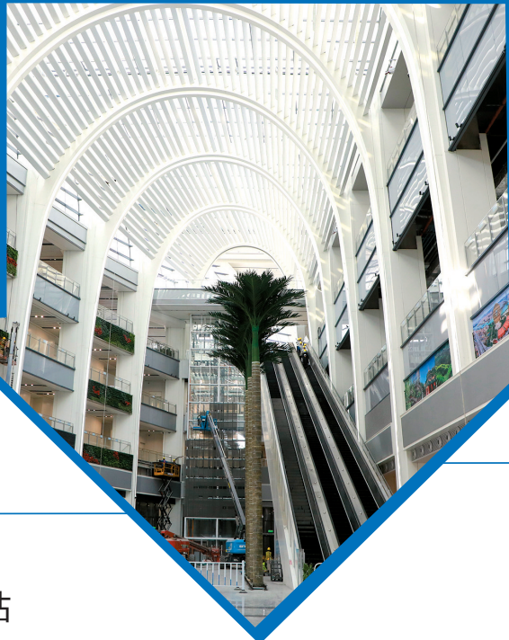
▼天窗+光导管采光系统将阳光导入高架候车层、站台层直至地下一层,一年可节约电力能源约147万千瓦。
