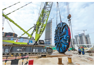
■在建的芳白城际项目再添“华隧初心号”盾构始发的刀盘吊装现场。 广州地铁供图
