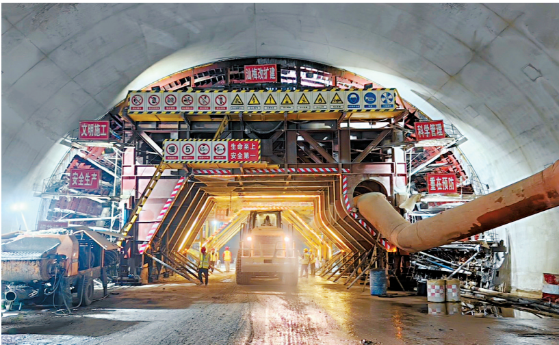
■工人正在进行二次衬砌施工准备。
