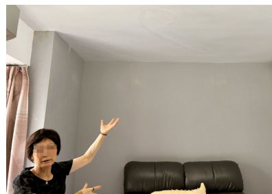
■ 梁阿姨的房顶修缮后依旧能看到渗过水的痕迹。
