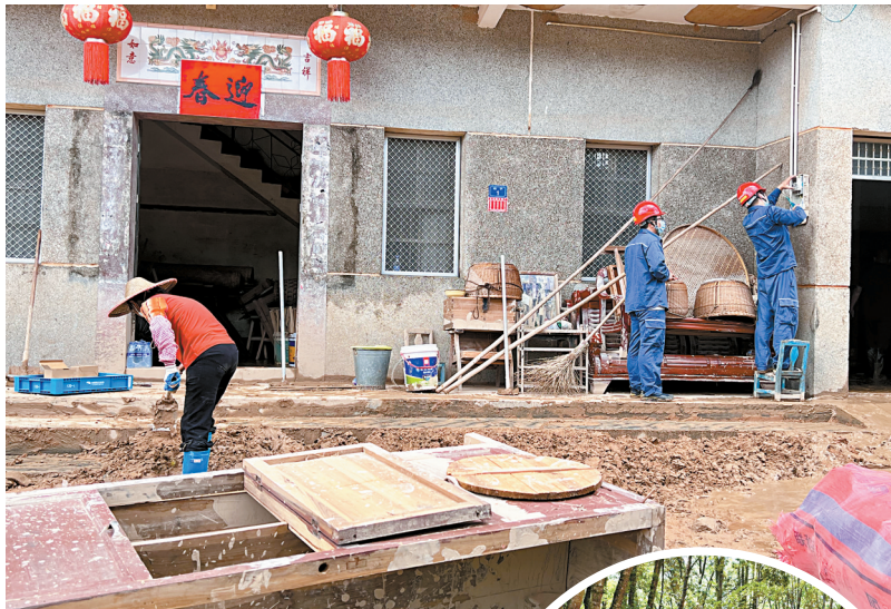
■6月20日,抢修人员在梅州平远县差干镇更换受损电表。 陈晓婷/摄
