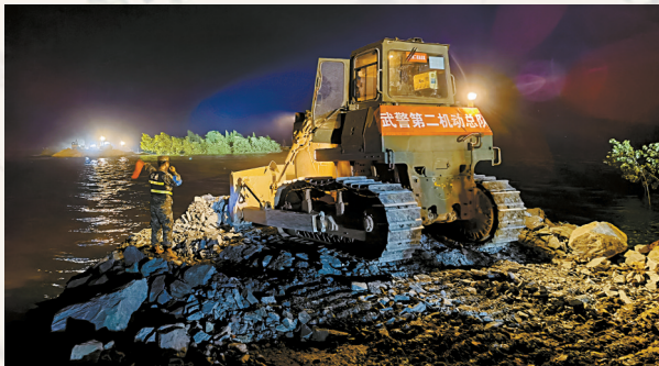
■7月7日凌晨,在湖南省岳阳市华容县团洲垸洞庭湖一线堤防决口处,武警部队官兵操纵工程机械封堵决口。
