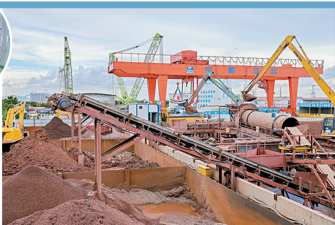
■7月18日,芳白城际六工区的洗砂设备对盾构弃渣进行砂土分离,处理后渣土可实现回收再利用。新华社发
