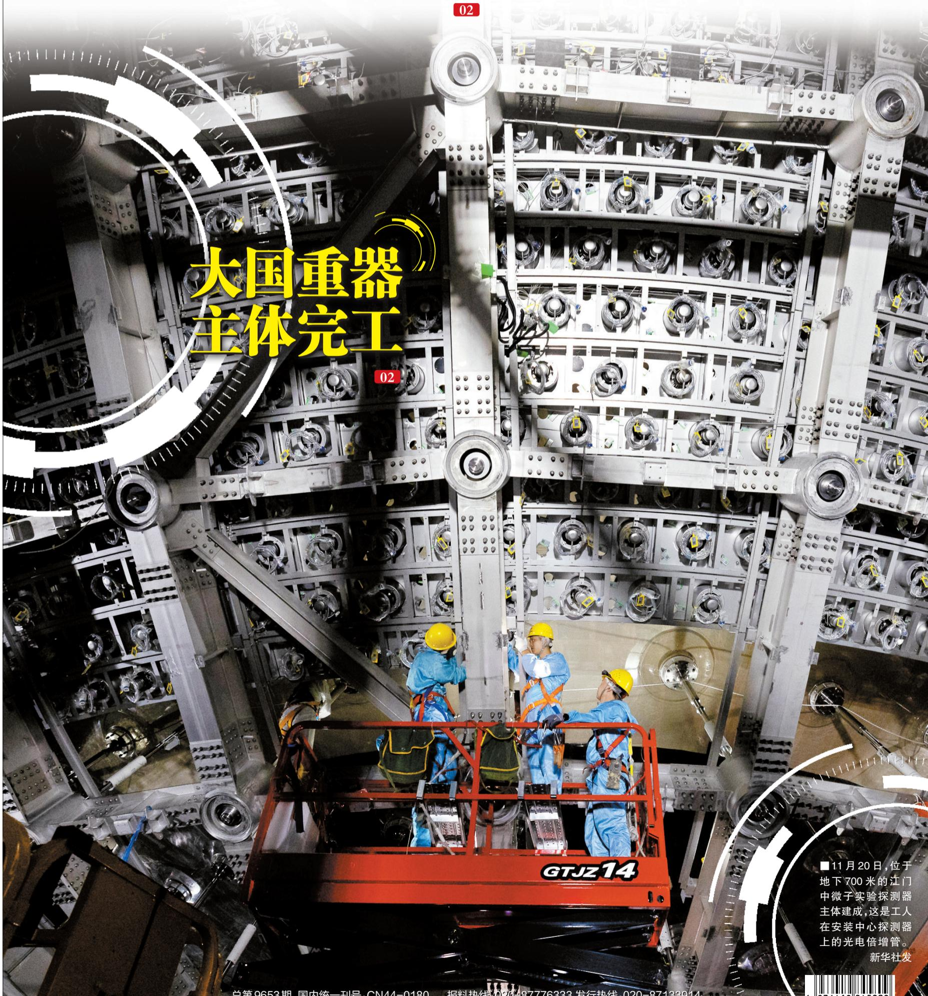
■11月20日,位于地下700米的江门中微子实验探测器主体建成,这是工人在安装中心探测器上的光电倍增管。
