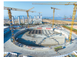
■狮子洋大桥东锚碇完成全部填芯施工。 雷健/摄
