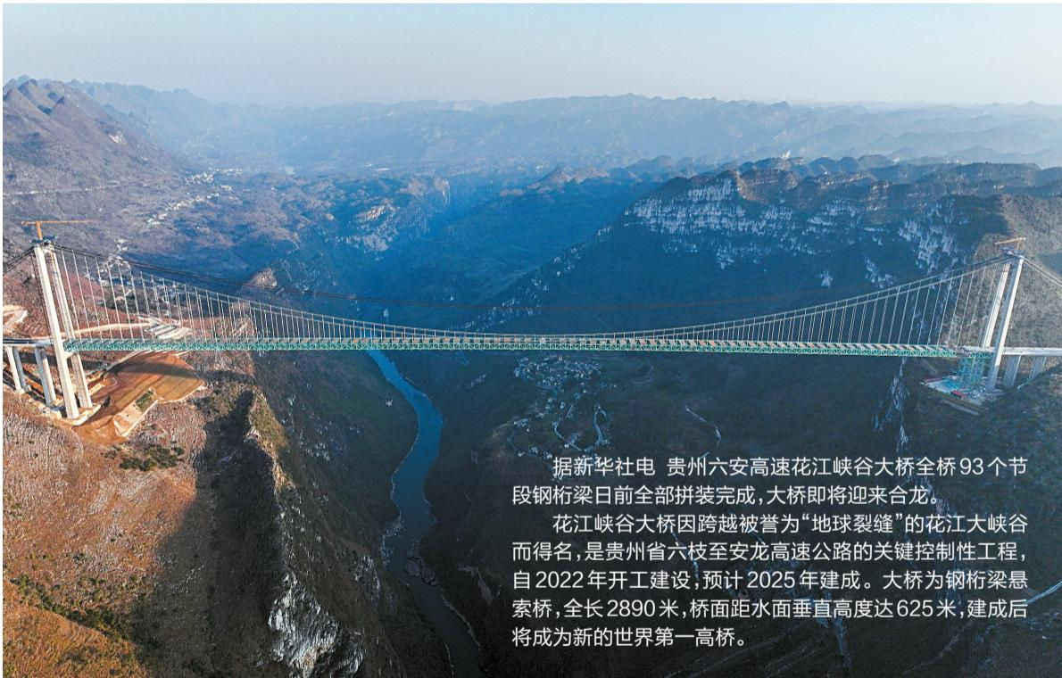
据新华社电 贵州六安高速花江峡谷大桥全桥93个节段钢桁梁日前全部拼装完成,大桥即将迎来合龙。
