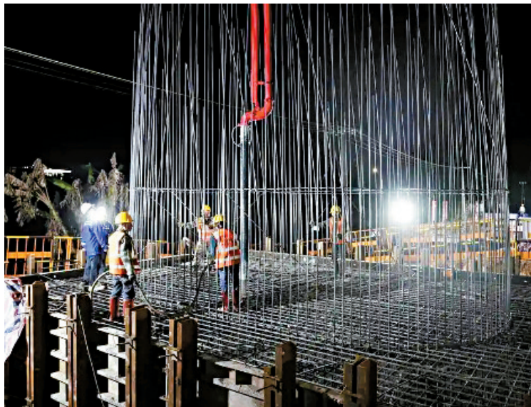
■承台混凝土浇筑现场。
