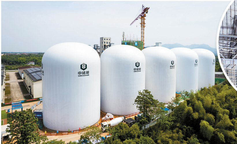
▲工人在气膜粮仓内部做结构层施工。 ◀我国首批5座9000吨级气膜粮仓充气成型。 新华社发
