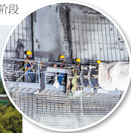
▲工人在气膜粮仓内部做结构层施工。 ◀我国首批5座9000吨级气膜粮仓充气成型。 新华社发
