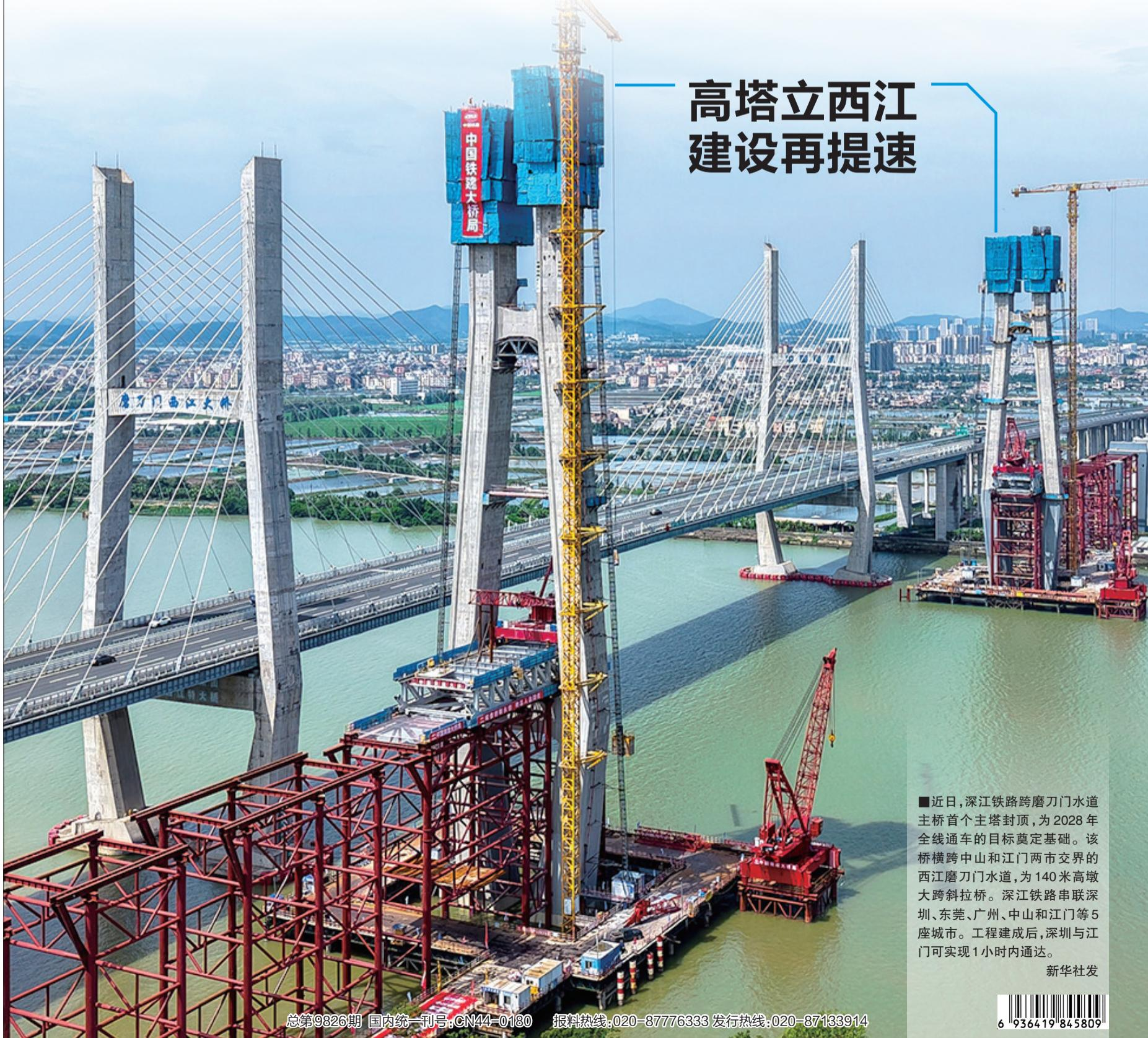
■近日，深江铁路跨磨刀门水道主桥首个主塔封顶，为2028年全线通车的目标奠定基础。该桥横跨中山和江门两市交界的西江磨刀门水道，为140米高墩大跨斜拉桥。深江铁路串联深圳、东莞、广州、中山和江门等5座城市。工程建成后，深圳与江门可实现1小时内通达。
