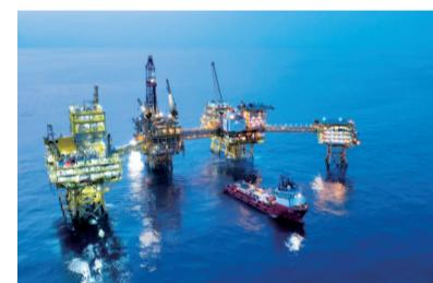
“深海一号”气田是我国迄今为止自主开发建设的作业水深最深、地层温压最高、勘探开发难度最大的深水气田,最大作业水深超1500米,地层最高温度达到138摄氏度,天然气探明地质储量超1500亿立方米,分两期开发建设。一期项目于2021年6月投产,二期项目在南、北、东3个井区部署12口水下气井,新建1座导管架平台、1套水下生产系统、5条海底管道及4条深水脐带缆,构建起地理跨度超170公里、水深跨度超1500米的超大规模油气生产设施集群。
