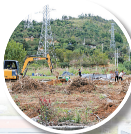
■正在建设的厂房。
