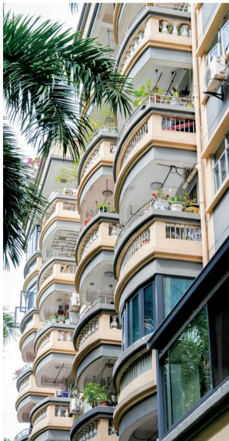
■老旧小区的斑驳外墙换上了靓丽新装。
