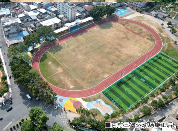
■丙村三堡体育场施工前。
